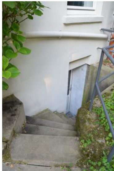
...war die Erneuerung der Fassade an so manch einer Stelle.
